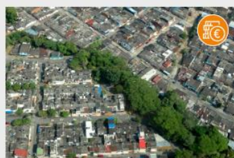
Recuperación de humedales en Villavicencio - Decretos 304 de 2020 y 152 de 2021
